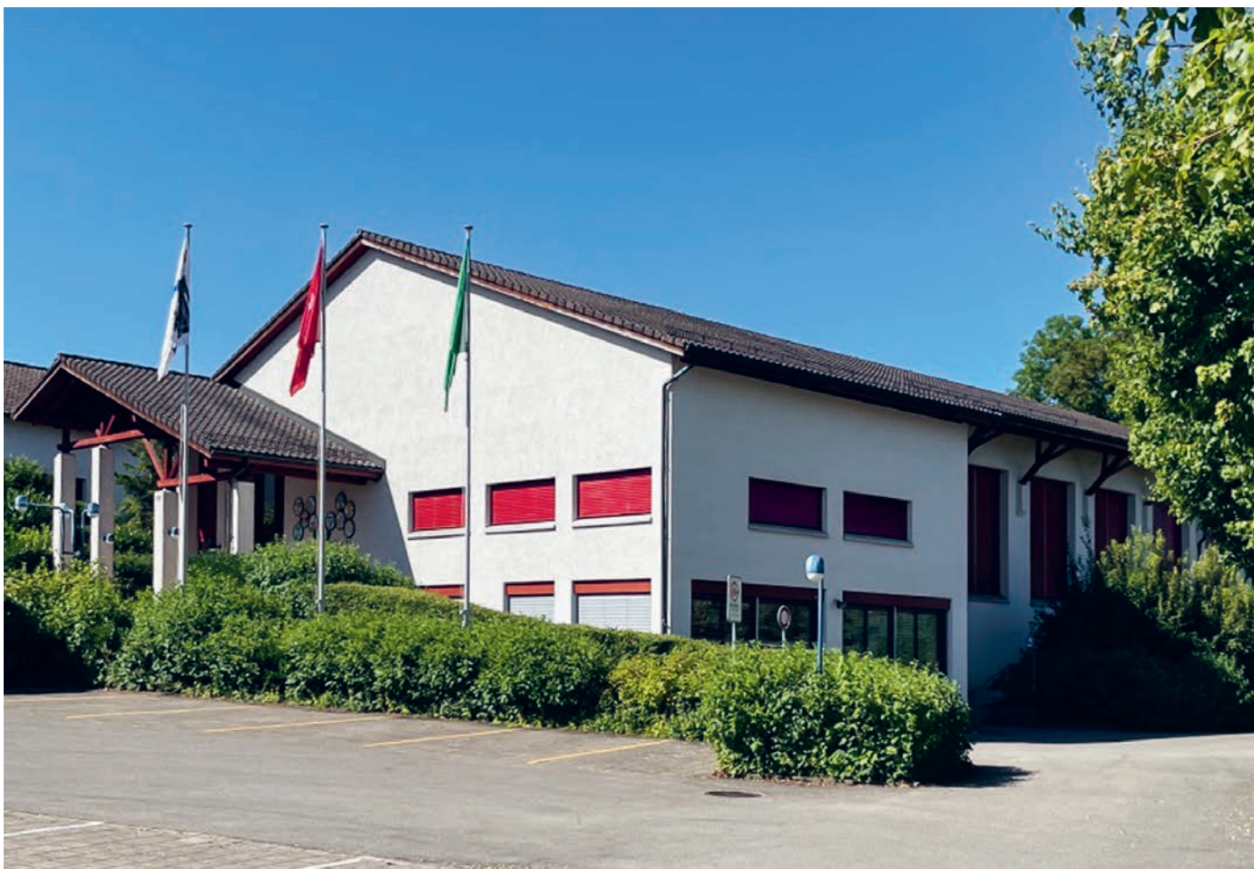
Bild: Mehrzweckgebäude Bernhardzell
