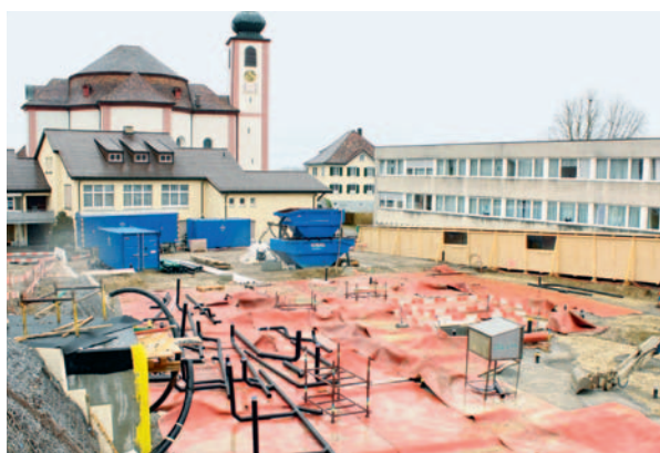
Spatenstich vom 19. November 2012 Übergabe des symbolischen Frankens am 15. März 2012 Bauarbeiten am Neubau Wiborada
